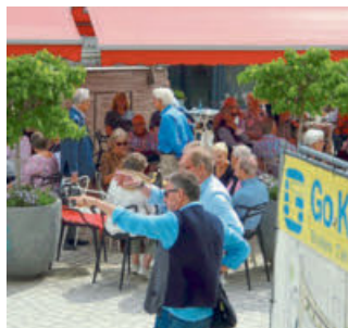
Flanier-Meile: Baustelle am Café Pammel (Marktstraße).
