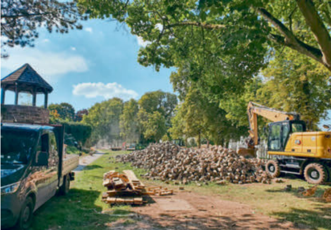
Die Wallanlagen werden für die Landesgartenschau bepflanzt, besonders mit heimischen Pflanzen. Zurzeit wird noch gebaggert.
