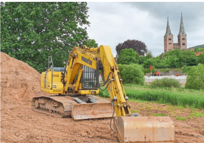
Auch am Floßplatz in Höxter wird gebaut: Parkplätze und Ausgleichsflächen werden geschaffen. Alle Fotos: Michael Robrecht
