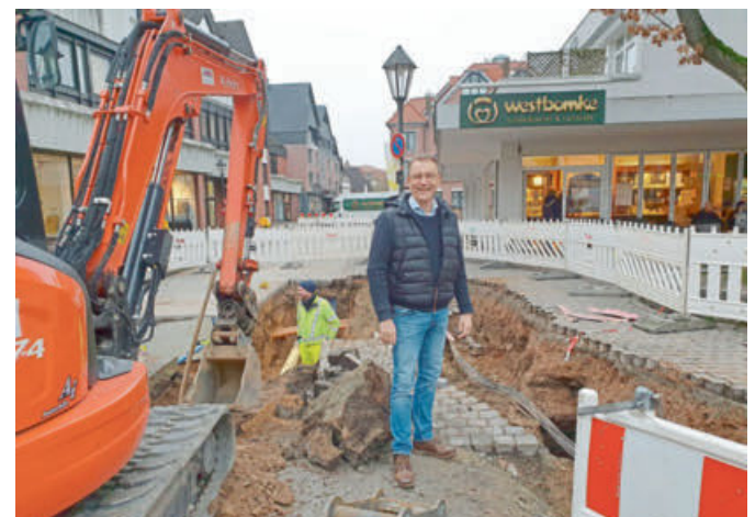
Bauunternehmer Elmar Düker schaut sich die Tiefbaustellen in der Marktstraße an, wo auch viele Kanäle ausgebessert worden sind.
