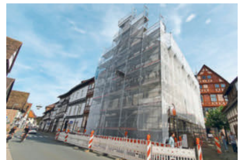
Und noch eine Baustelle: das Tillyhaus wird zum Anja-Niedringhaus-Forum mit zwei Wohnungen.
