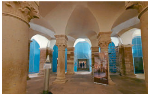
Auch Welterbe Corvey ist Großbaustelle (hier das Westwerk). Der Klostersgarten wird rekonstruiert.
