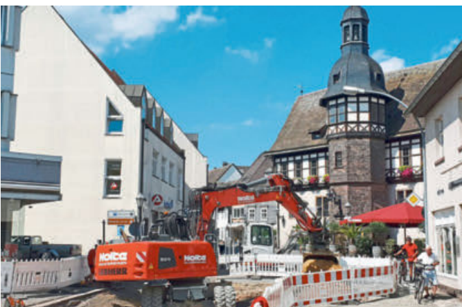
Kanäle sind in der Weserstraße vor der Brücke verlegt worden. Das benachbarte Bahnhofsumfeld wird 2022 auch völlig neu gestaltet.
